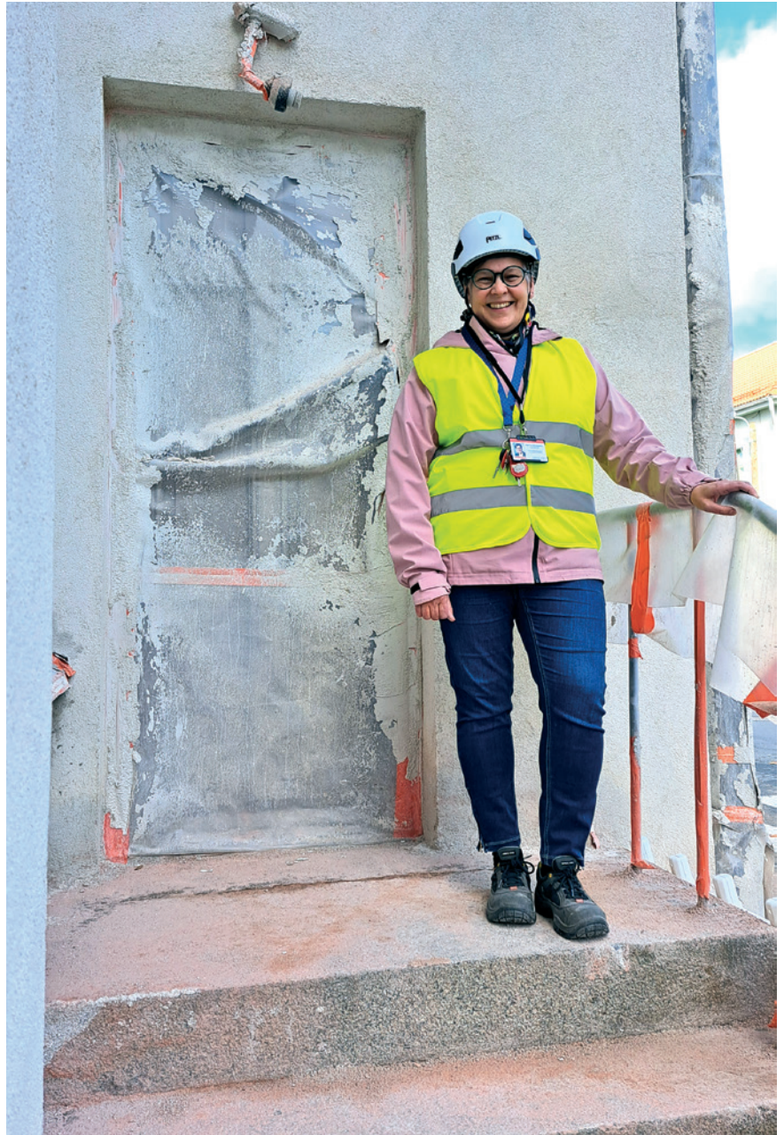
Renoveringen av Brändö kyrkas fasad framskrider etappvis. Fastighetschef Reetta Hietaharju följer arbetet på plats ungefär en gång i veckan. De nyputsade fasadytorna ska ännu målas.
